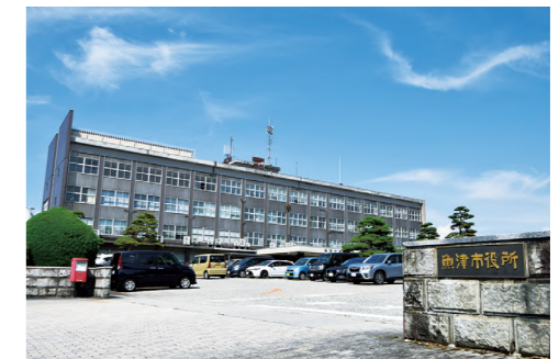
災害支援のため製品を提供した魚津市役所 提供：魚津市役所
